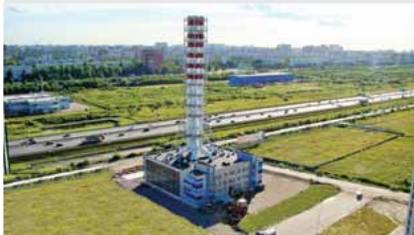
«МОЭК» и «Сибирская энергетическая компания» котельные в московском и сибирском регионах
