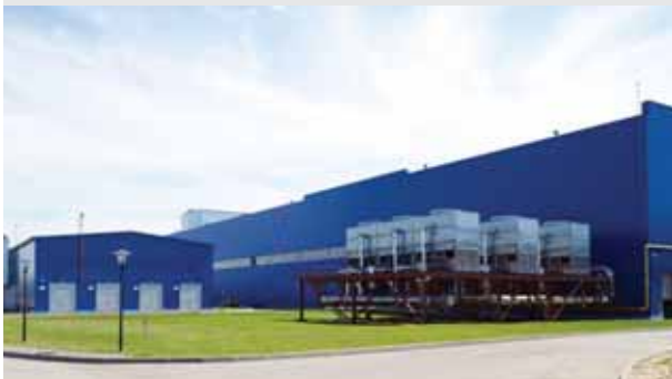
«Яндекс» дата-центр в Рязанской области
