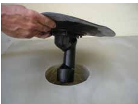
1. Корпус трапа вставить в предназначенное для него отверстие в плите перекрытия и закрепить.
