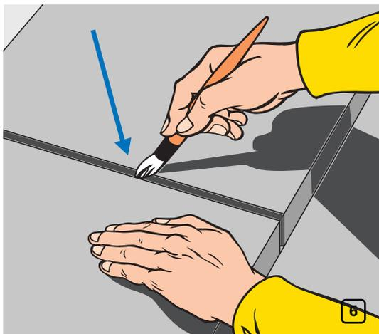
Склейте вместе края теплоизоляции при помощи клея K-FLEX K-404 (рис. 6).
